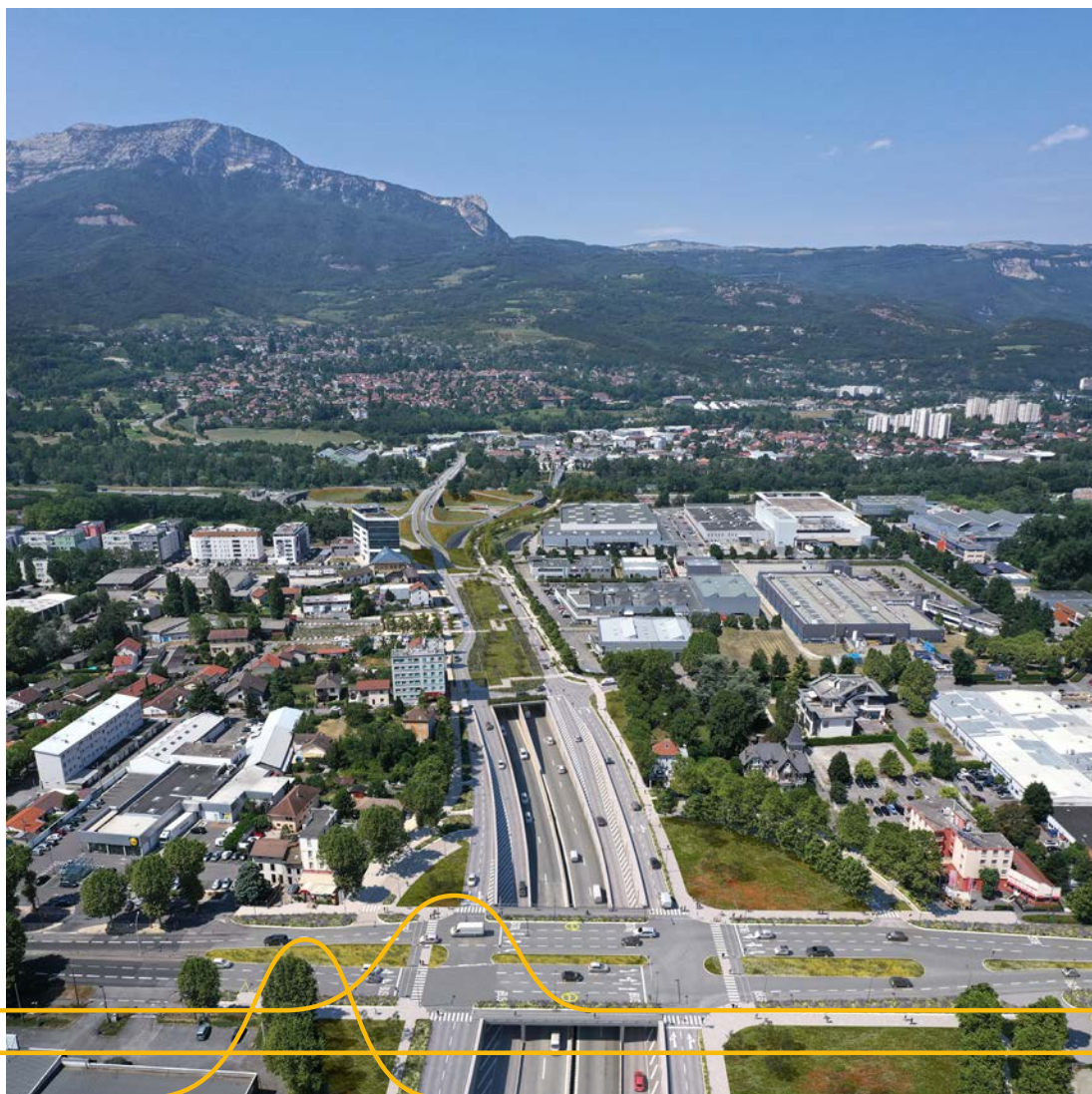
Perspective est ouest depuis la N87 après travaux
